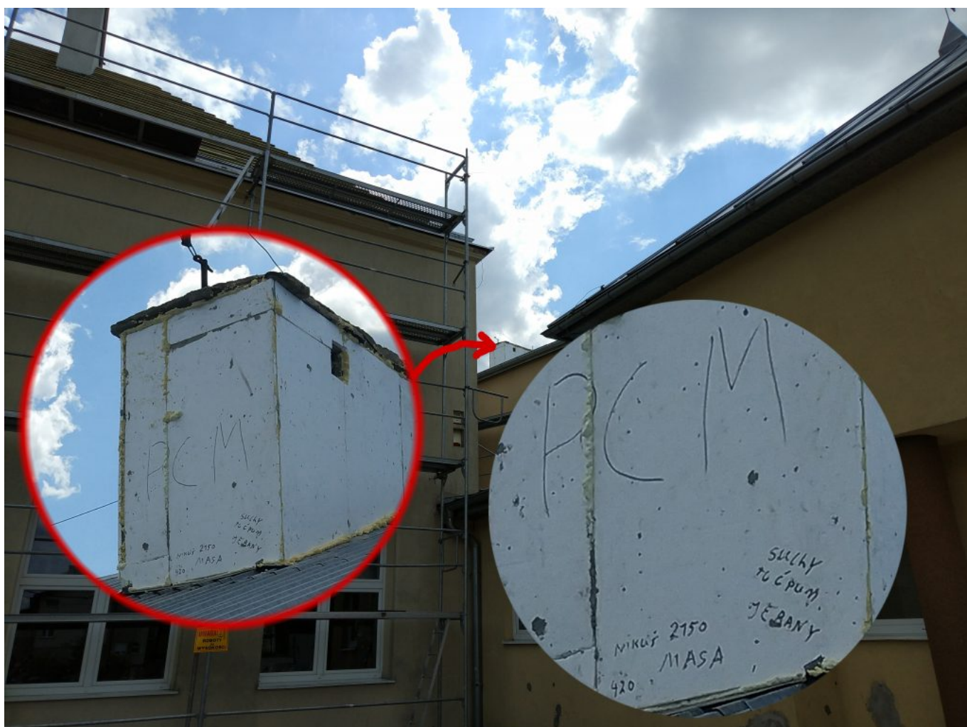
Daszek nad wejściem do budynku szkoły
